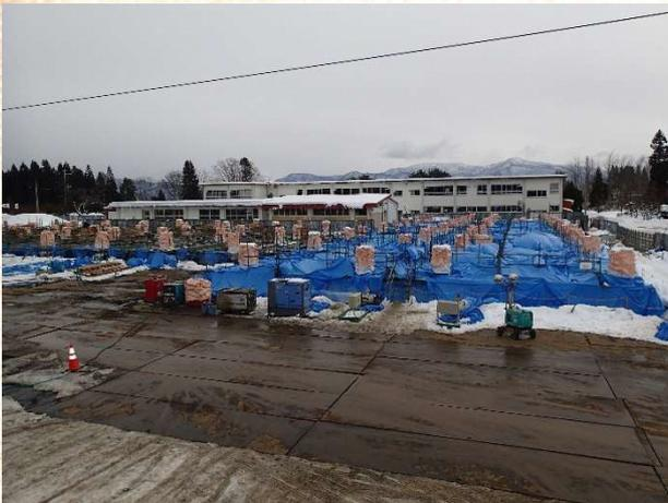
杭工事の終了後から進めてきた基礎工事ですが、一部コンクリートの打設まで終了しています。
